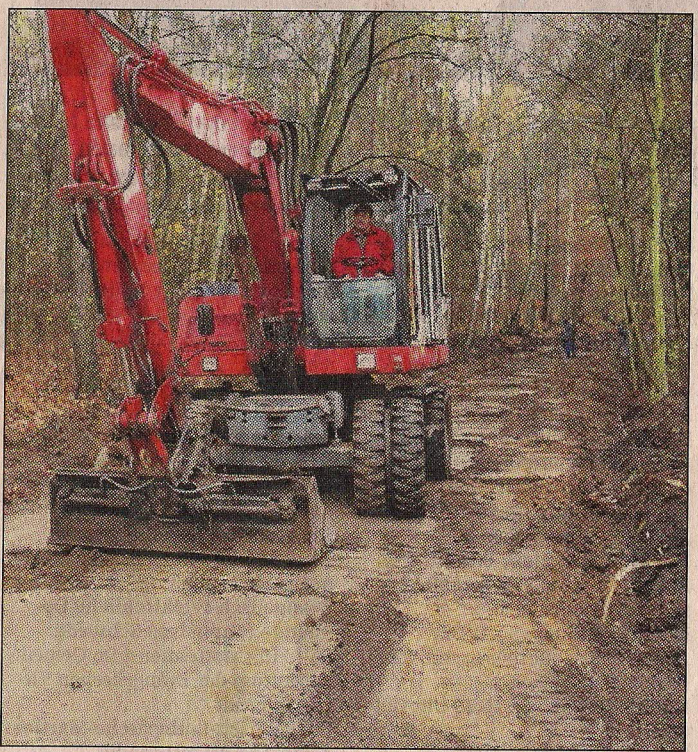
Gesperrt bis Frühjahr: Die Firma Rask baut die Straße zum Wolletzsee. Im April soll sie fertig sein.
